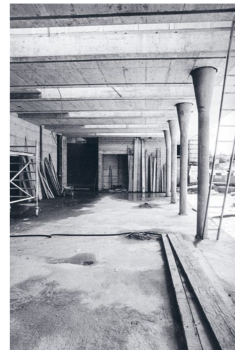
Das Restaurierungsatelier im Rohbau
