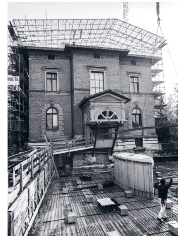
Umbau der Villa Bleuler, Baustelle im Eingangsbereich
