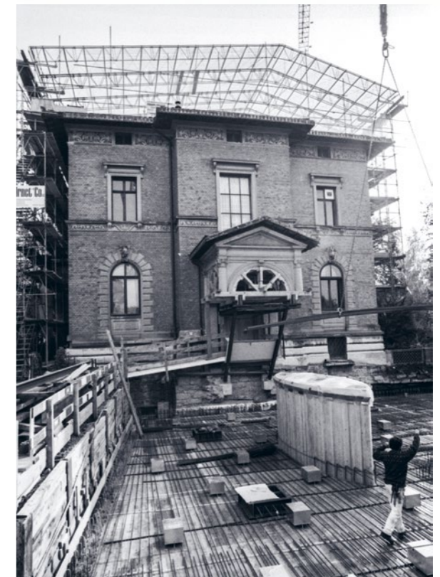
Umbau der Villa Bleuler, Baustelle im Eingangsbereich
